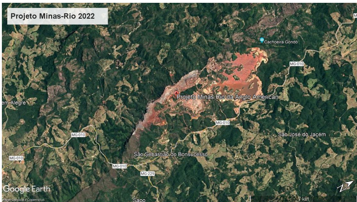
Figura 6 - Área que compreende o projeto Minas-Rio, depois de sua implantação e expansão, em 2022
