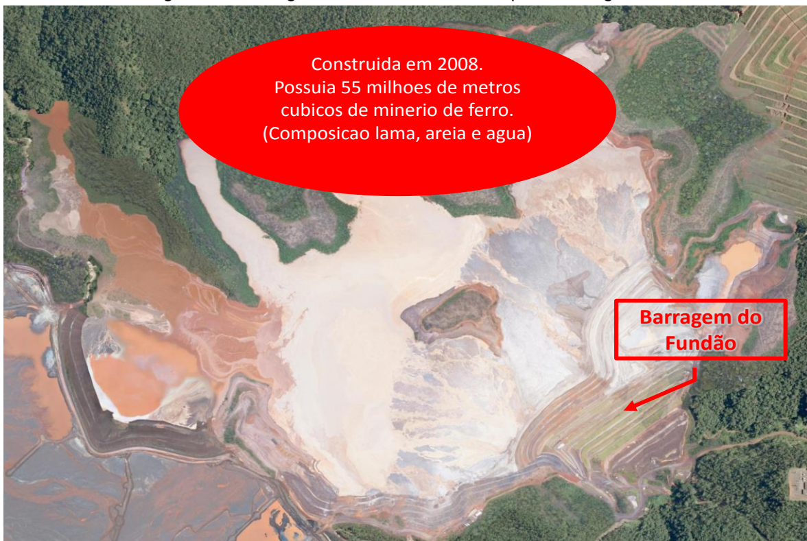
Figura 11 - Barragem de Fundão antes da ruptura – imagem aérea
