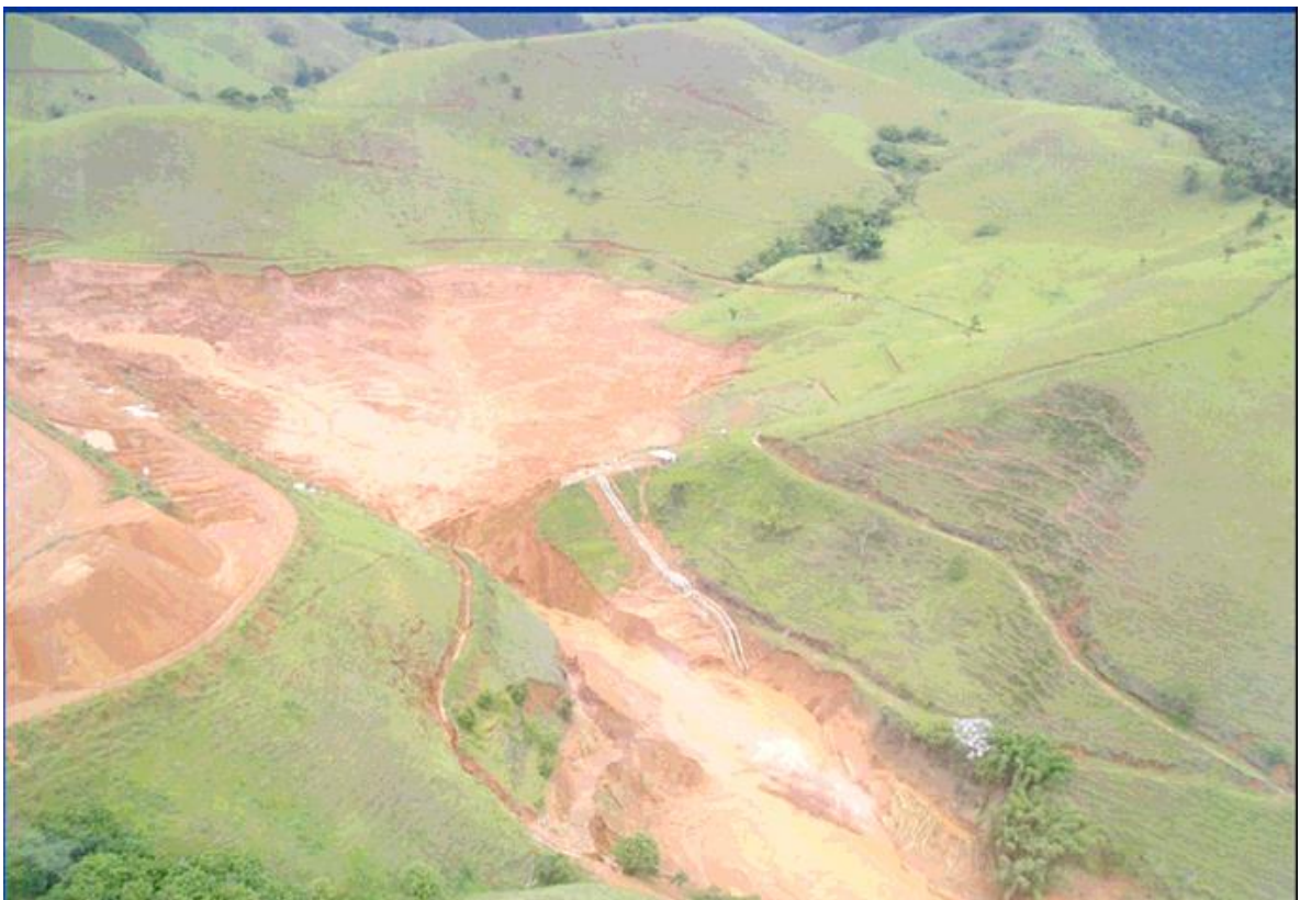
Figura 6 - Vista da ruptura da barragem São Francisco - Miráí
