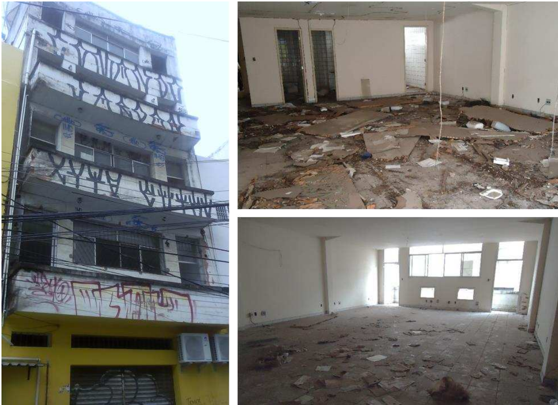
Figura 1 – Fotos do imóvel denominado Edifício Percy
