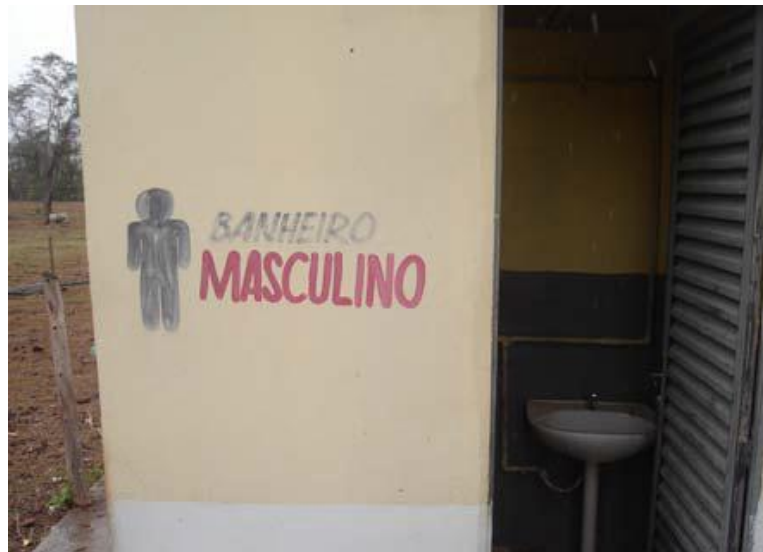
FOTO 5: Módulo construído em campo de futebol
