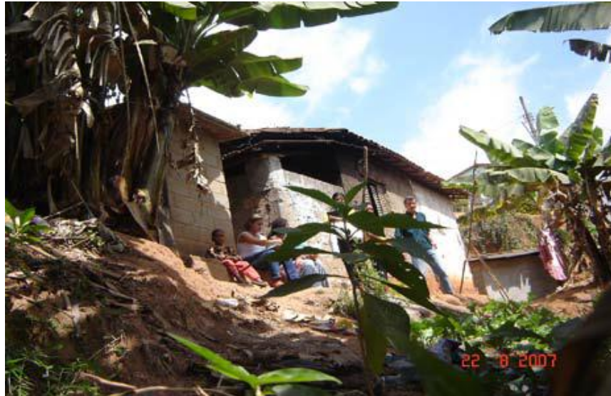
FOTO 1: Casa em local de risco
