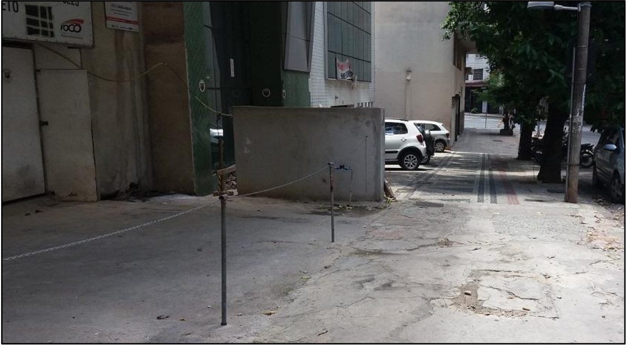
Recuo da fachada, no nível da rua, de um prédio em construção na rua Sergipe, esquina com rua dos Guajajaras. Fonte: O autor (2017).
