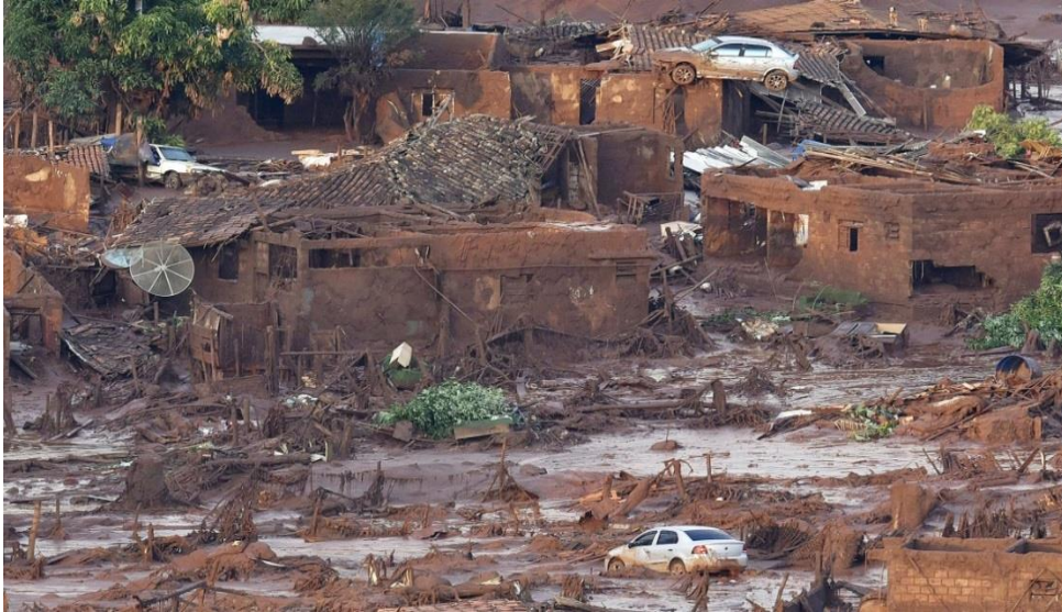
Figura 1 – Bento Rodrigues, após a passagem da lama de rejeitos
