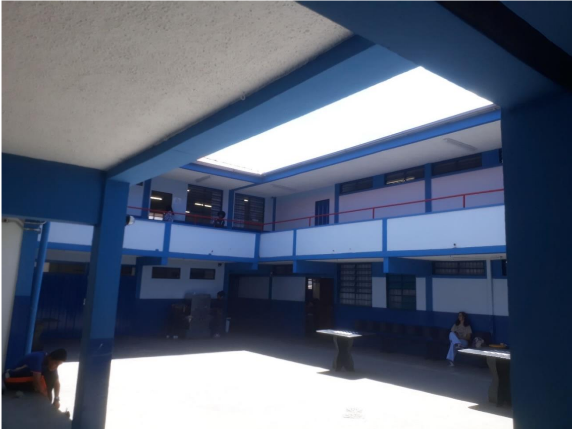
Fotografia 2.3 - Vista interna do pátio e corredores da escola 2
