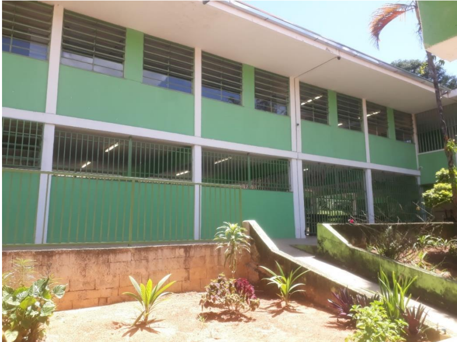
Fotografia 3.2 - Cantina e salas superiores da escola 3
