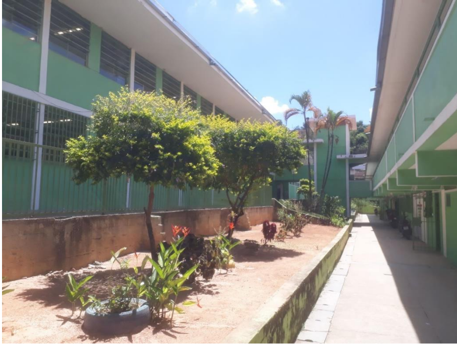
Fotografia 3.1 - Corredor principal da escola 3
