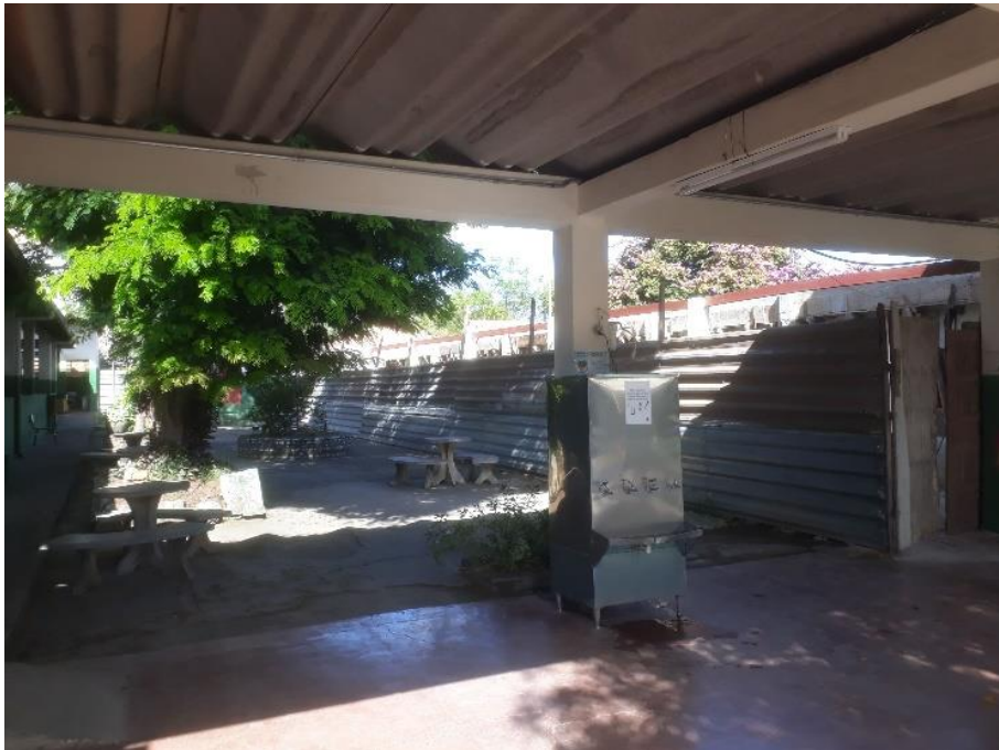
Fotografia 1.3 – Vista da obra que está sendo realizada na escola
