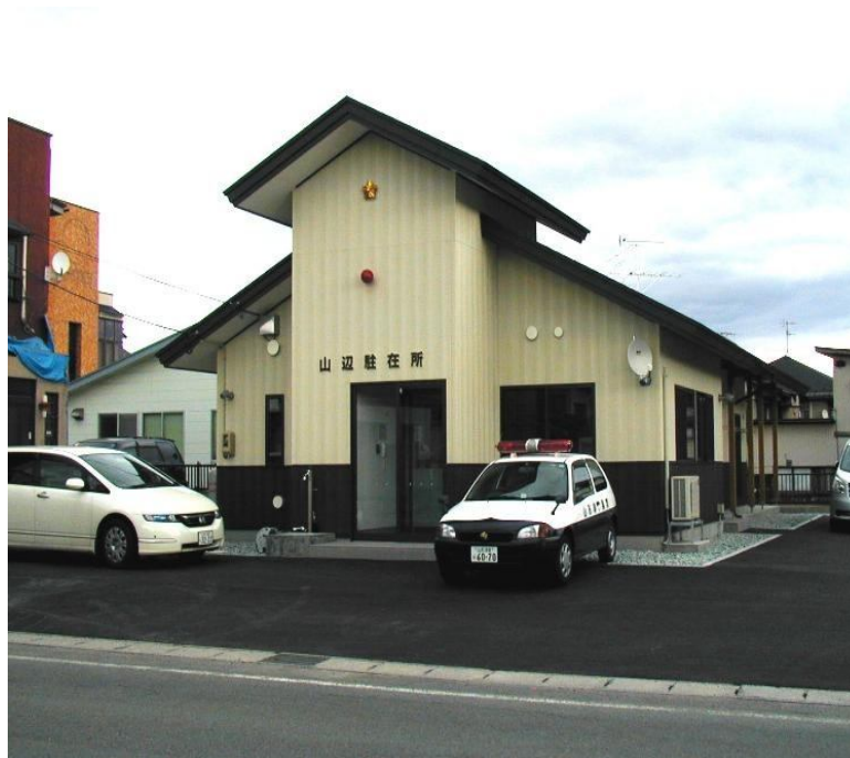
Figura 6: Local de funcionamento de chuzaisho instalado na província de yamanobe - Japão
