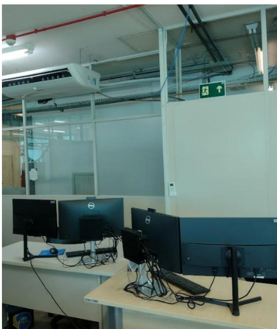
drywall e vidro
