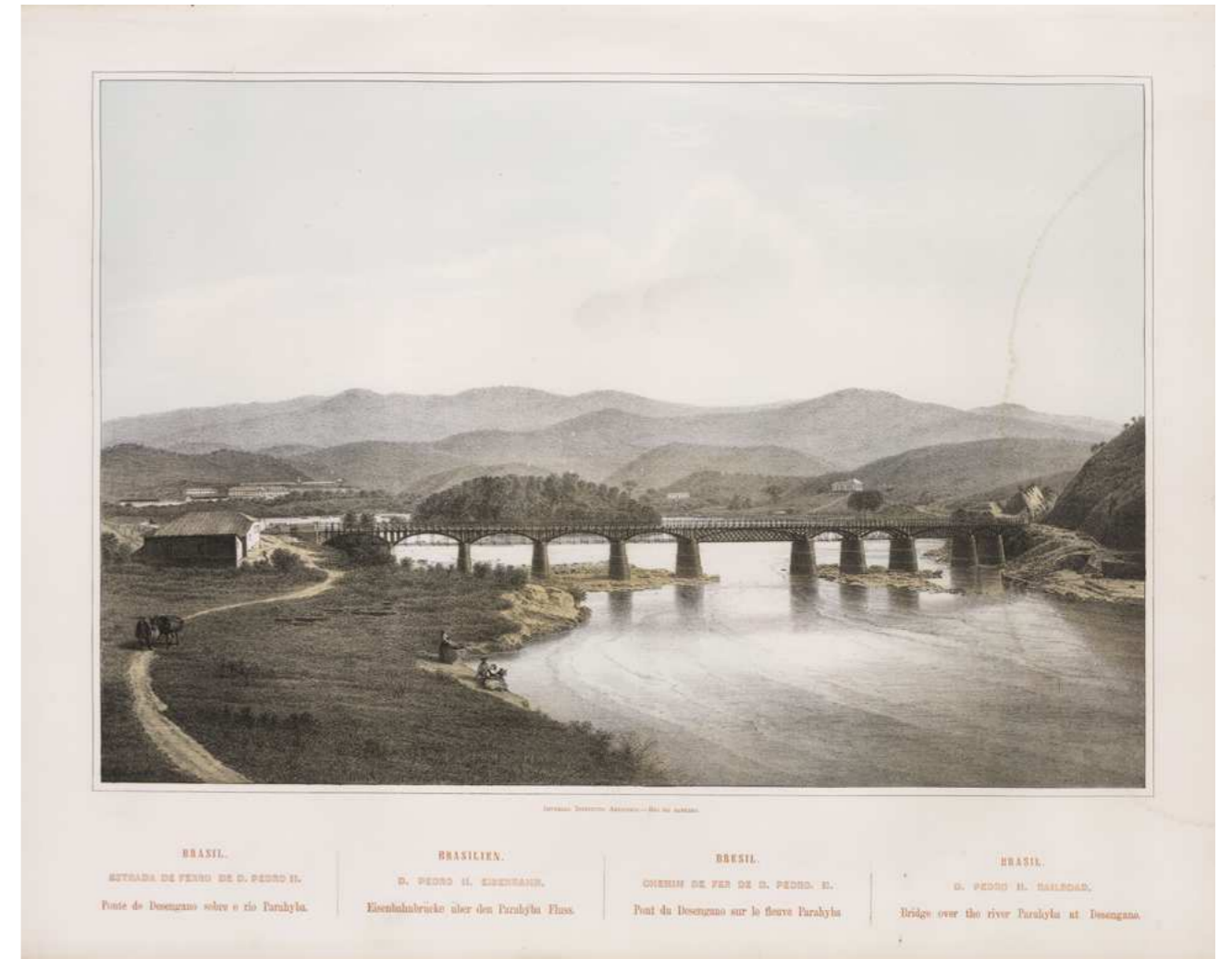
Ponte do Desengano sobre o rio Paraíba, Rio de Janeiro
