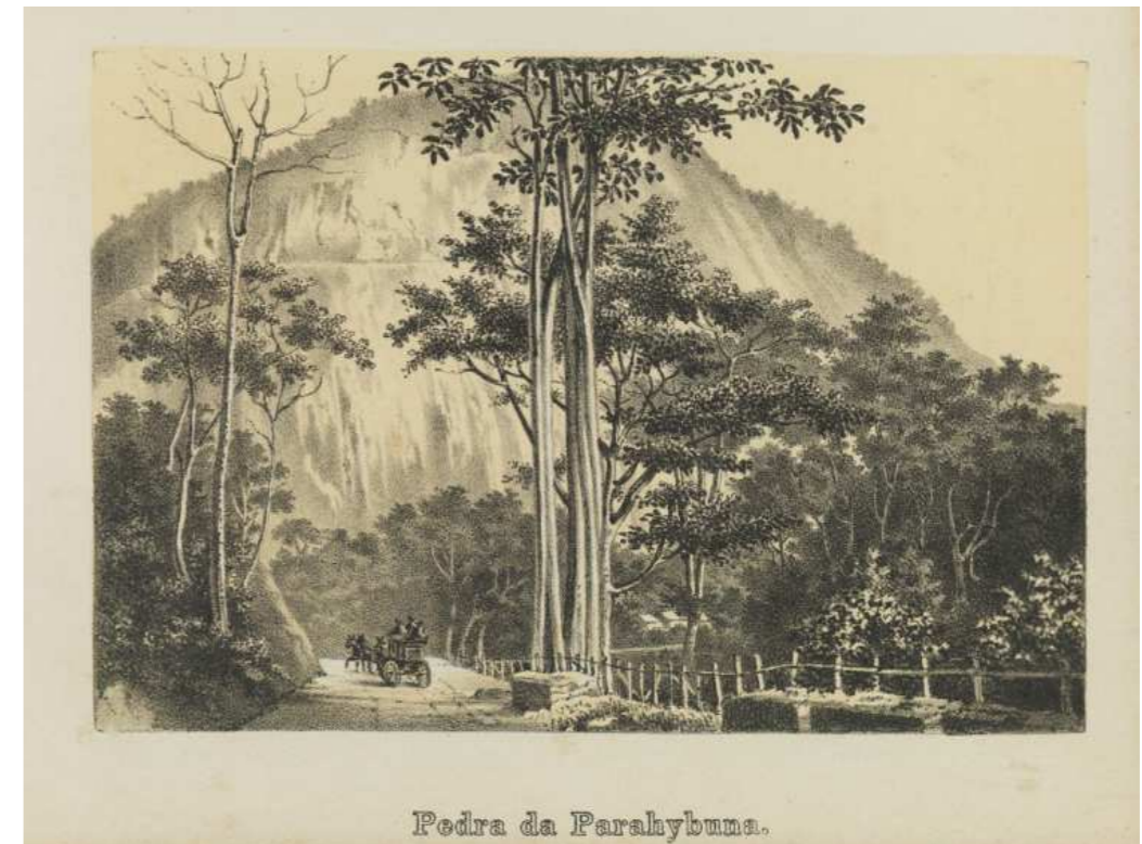
Diligência da Companhia União Indústria e vista da pedra da Paraibuna
