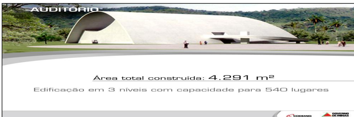
FIGURA 11 - Auditório do Centro Administrativo de Minas Gerais. Fonte: CODEMIG/ Governo de Monas Gerais.
