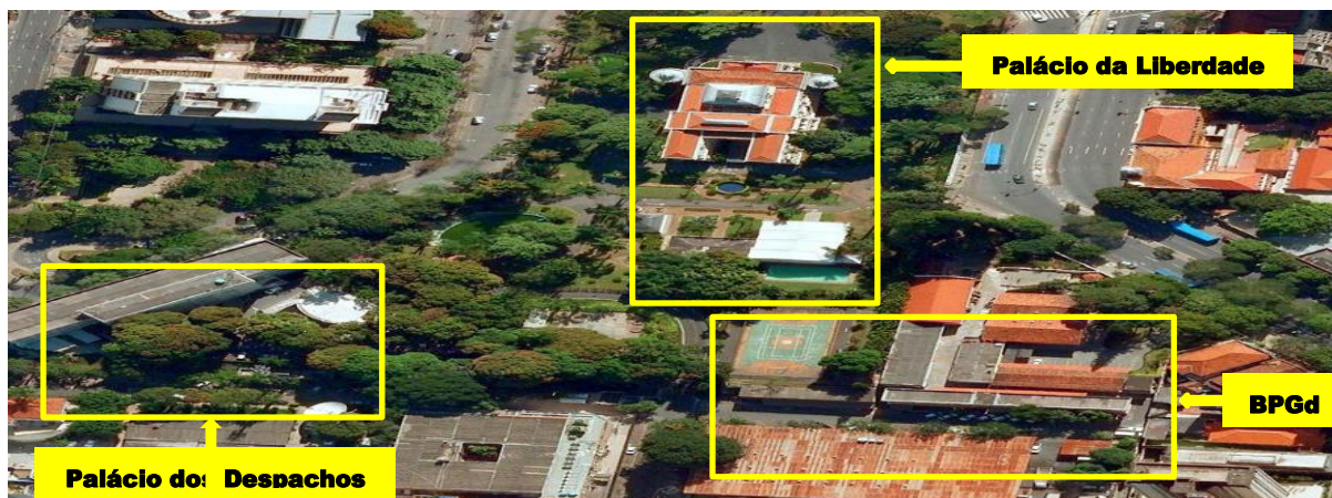
FIGURA 7 - Vista aérea do Palácio da Liberdade, Palácio dos Despachos, QCG e BPGd. Fonte: Seção de Comunicação Organizacional do BPGd/CPE/PMMG. (destaque nosso)
