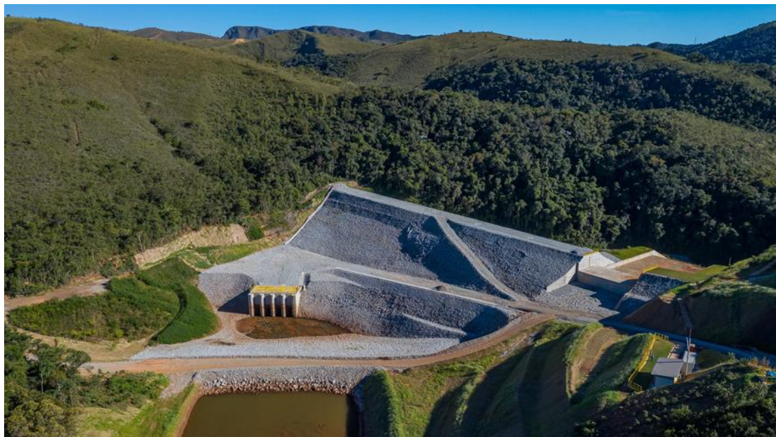
Figura 8. Estrutura de contenção a jusante da barragem B3/B4
