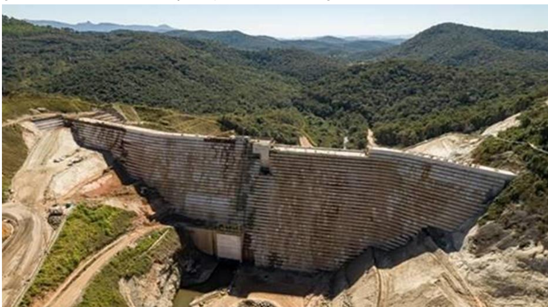
Figura 7. Estrutura de contenção a jusante das barragens da Mina de Fábrica
