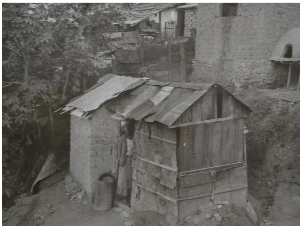
Figura 2 – Habitação precária na Pedreira Prado Lopes, B. H te (MG), 1955
