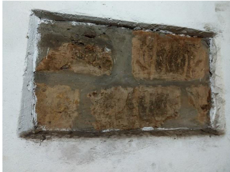
Figura 1 - Janela de prospecção de adobe localizada na Igreja do Pilar em Ouro Preto/MG 1
