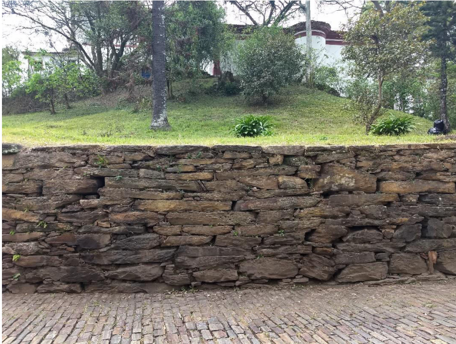
Figura 7 - Muro de pedras
