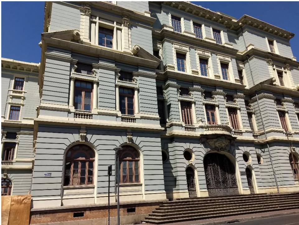
Figura 13 - Prédio da antiga secretaria da viação, localizado na Praça da Liberdade em Belo Horizonte construído em alvenaria realizada entre 1895 e 1897.
