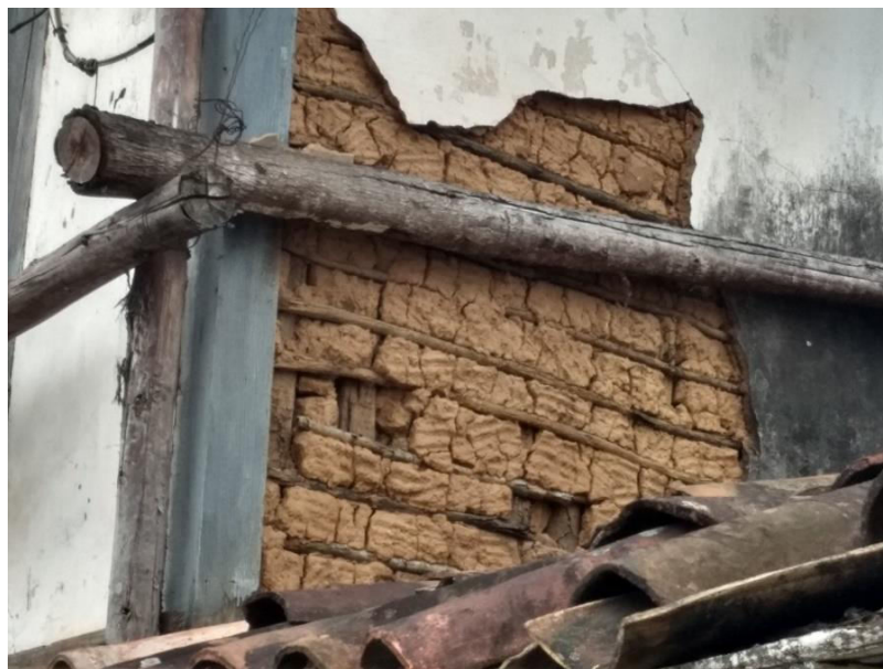
Figura 5 - Parede com “pau a pique” em Ouro Preto/MG
