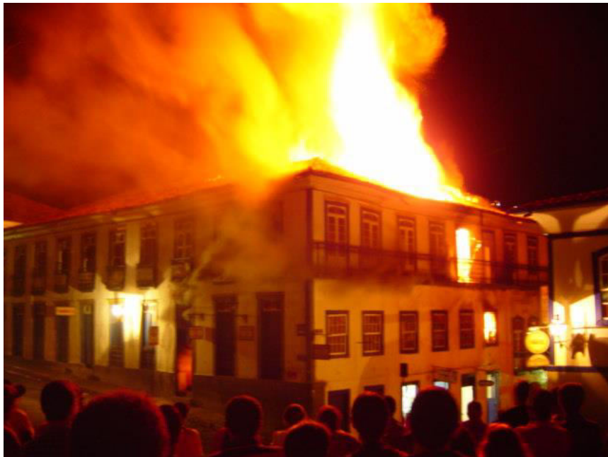
Figura 20 - A edificação já tomada pelas chamas
