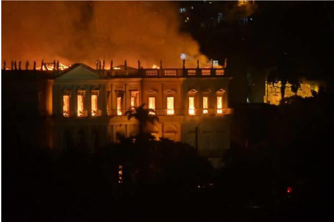
Figura 23 - A edificação já tomada pelas chamas.
