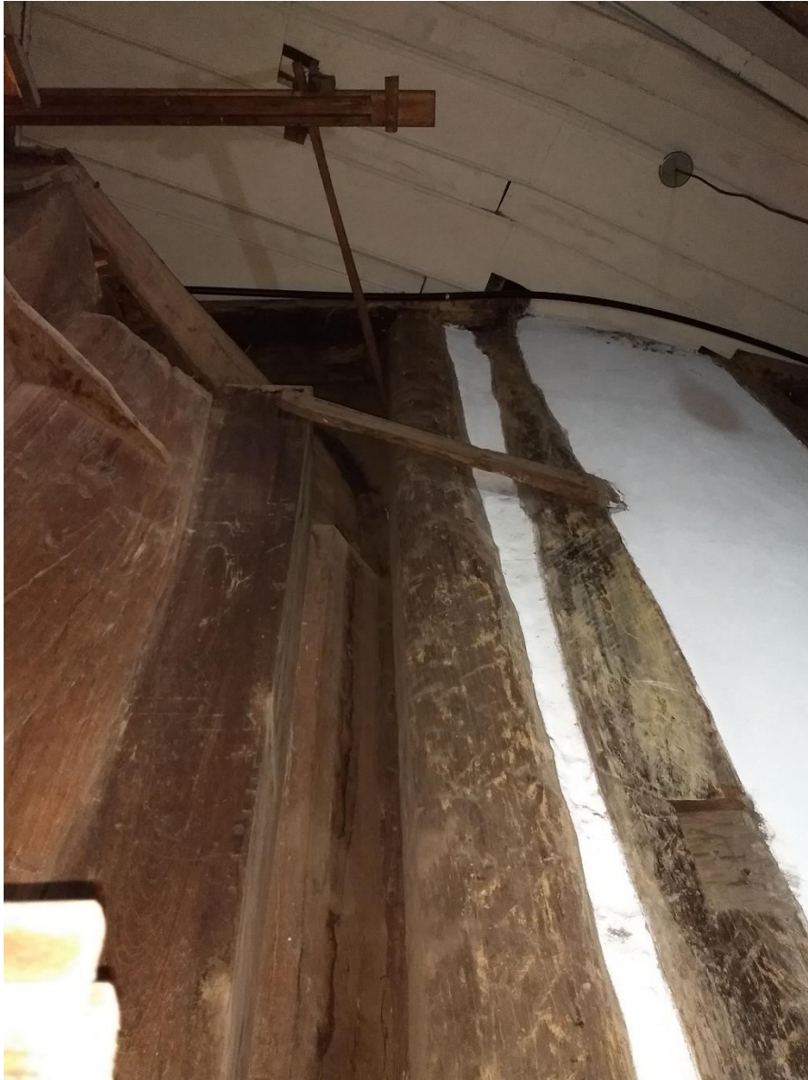
Figura 8 - Madeira utilizada para construir a nave das igrejas 2
