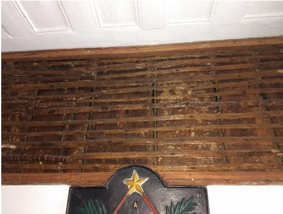
Figura 9 - Janela de prospecção de tabique, encontrada no “hall” de entrada da câmara municipal da cidade de Ouro Preto.
