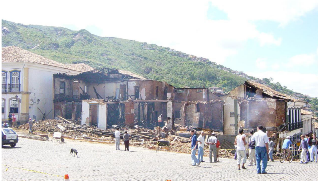
Figura 21 - A edificação em ruínas no dia seguinte ao incêndio.
