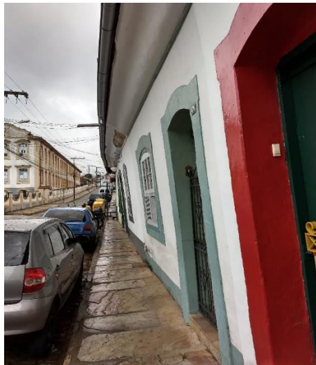
Figura 4 - Paredes de taipa de pilão
