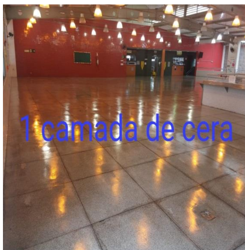
4° Passo: Enceramento do piso
