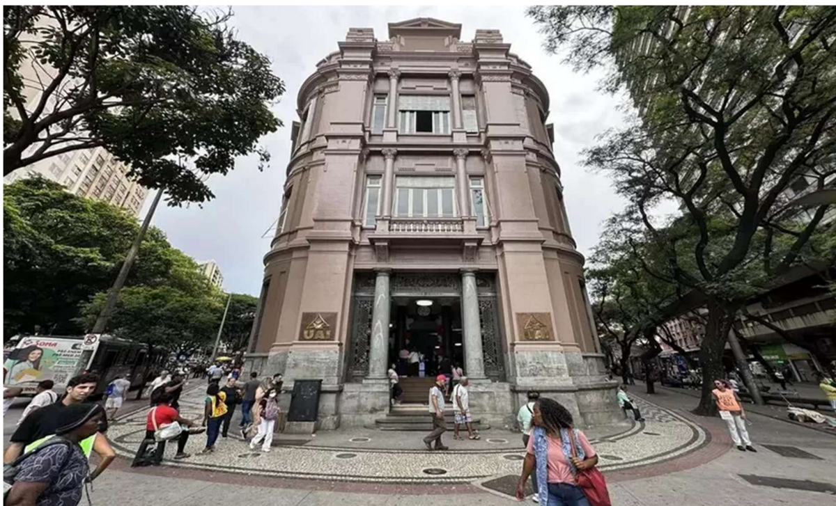
Figura 6: Fachada principal da UAI Praça Sete, em Belo Horizonte
