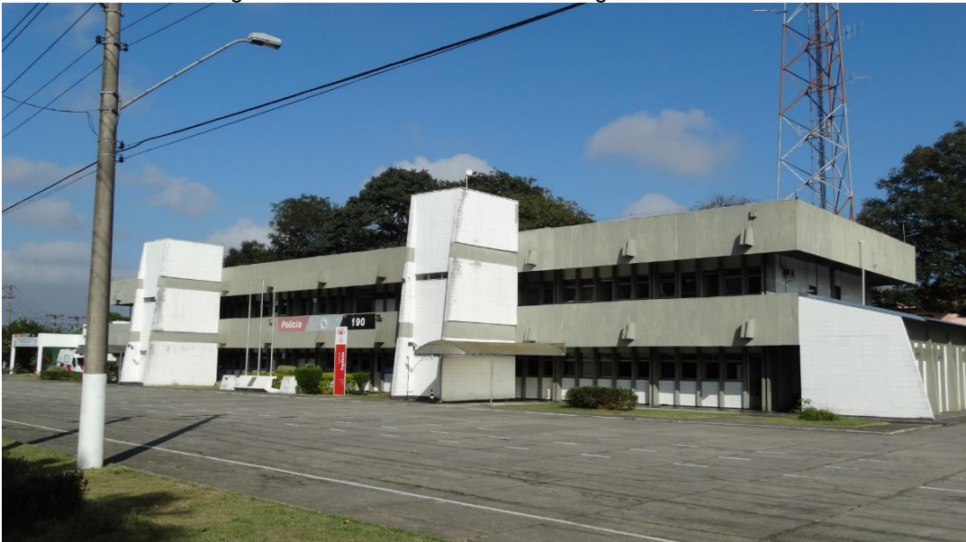
Figura 11 - Fachada do COPOM Regional do CPI-1
