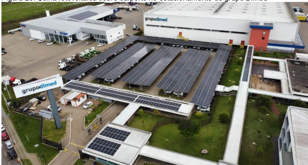
Figura 26: Usina fotovoltaica sobre carports no estacionamento do grupo Dimed
