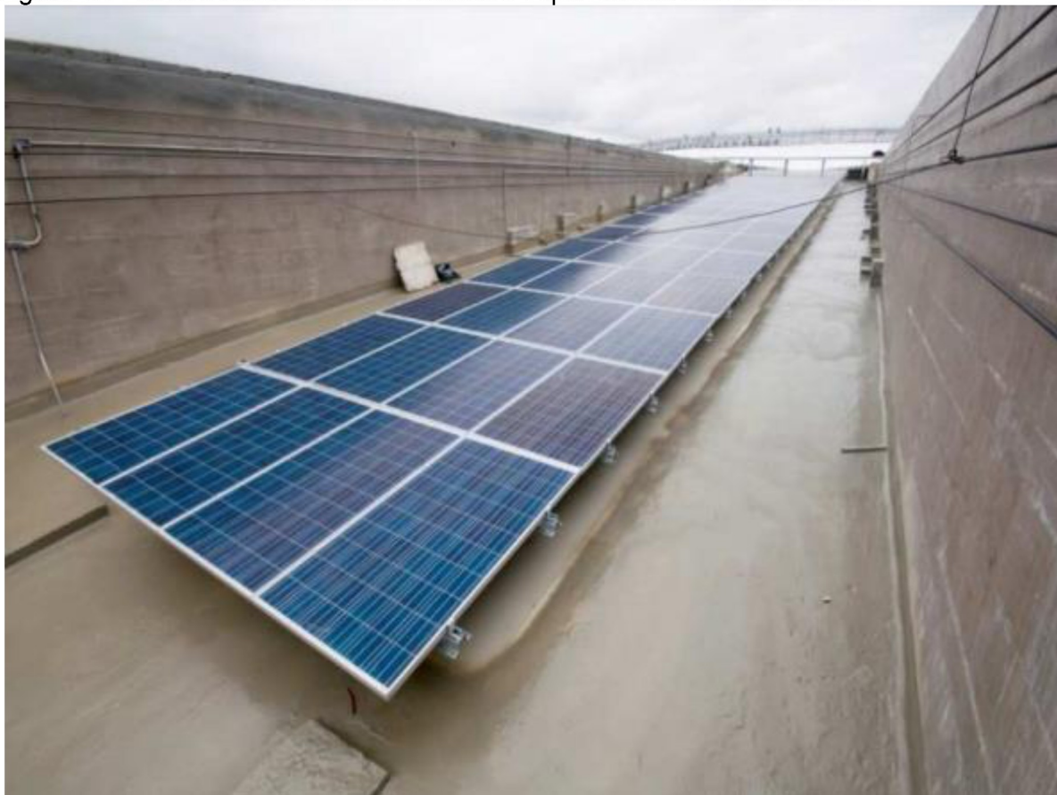
Figura 12: Painel montado sobre a cobertura impermeabilizada do Mineirão
