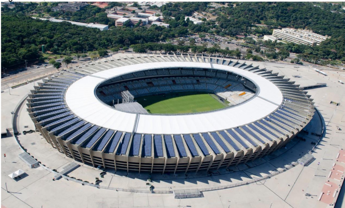
Figura 13: Cobertura do Mineirão com os módulos fotovoltaicos instalados
