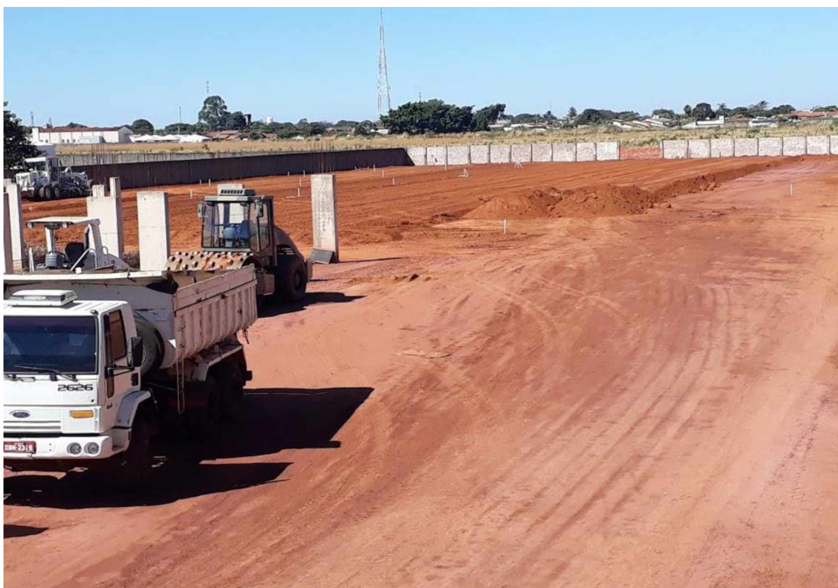
FIGURA 21: Trabalhos de construção da Nova Sede da 2ª Companhia de Bombeiros Militar.
