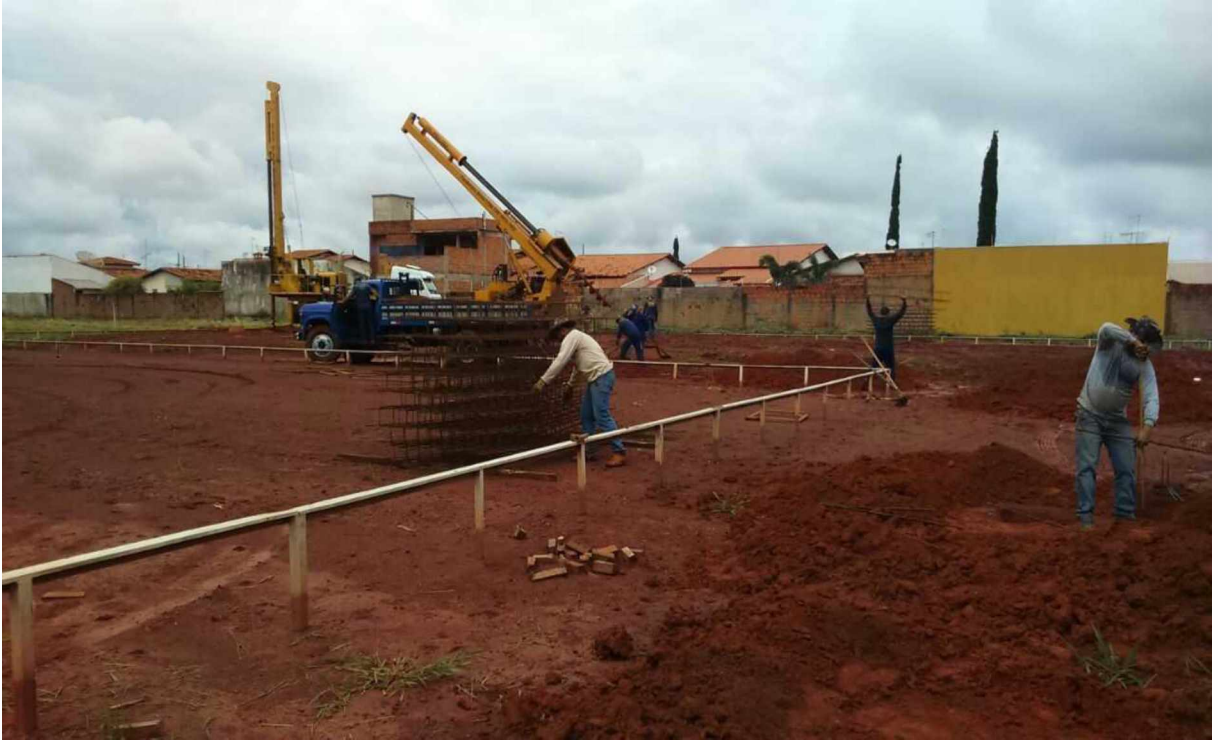
FIGURA 18: Trabalhos de fundação para a construção da Nova Sede da 2ª Companhia de Bombeiros Militar.
