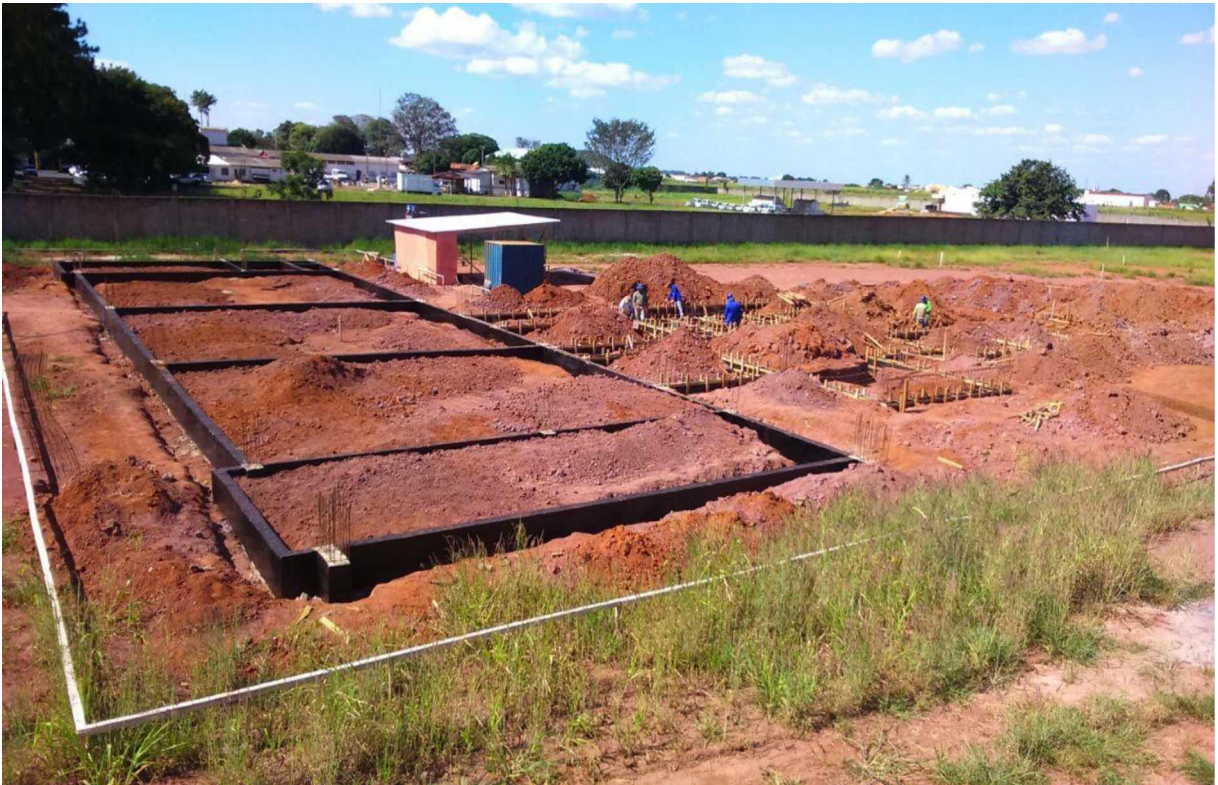
FIGURA 19: Trabalhos de construção da Nova Sede da 2ª Companhia de Bombeiros Militar.
