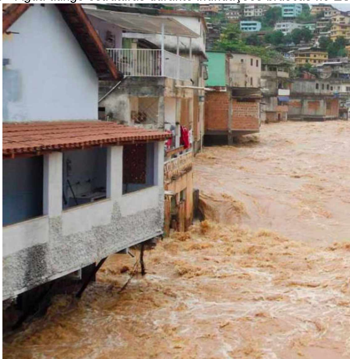
Figura 08 - Água atinge estruturas durante inundações bruscas no ES em 2009.
