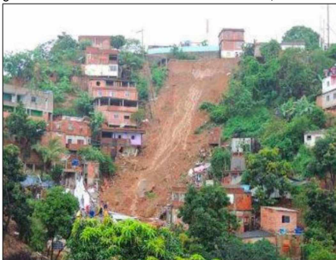
Figura 09 - Deslizamento no bairro São Marcos, Colatina/ES.
