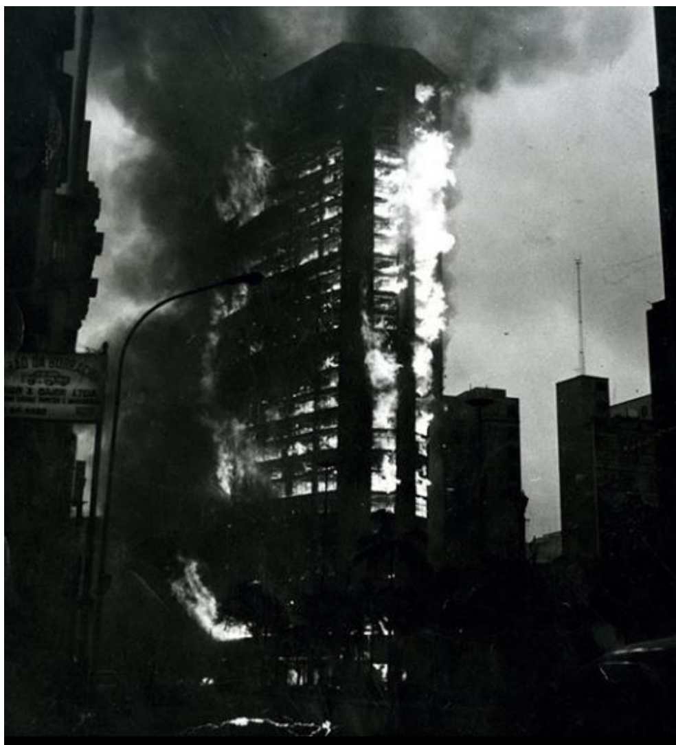
FIGURA 2 – Incêndio no Edifício Andraus
