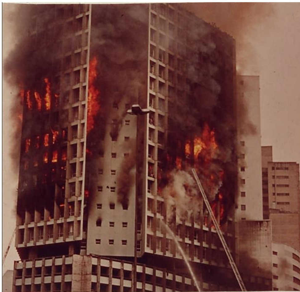
Figura 4 – Incêndio no Edifício Joelma
