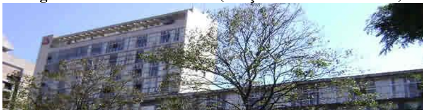
Figura I – Sede do IPSEMG (Praça da Liberdade - MG)
